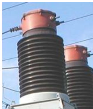
Fig. 2 - Transformatoare de măsură de curent
